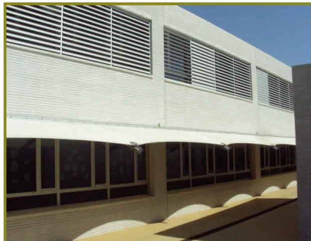
Vela tensada CEIP Gavà Mar. Barcelona
