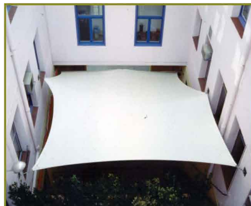
Sombra textil patio interior edificio FECSA Barcelona. Tejido impermeable Précontraint 702.
