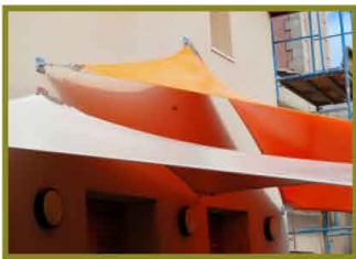
Velas tensadas terraza vivienda unifamiliar. Barcelona
