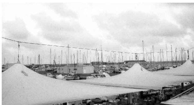
Vela tensoestática de 3 cuerpos para terraza. Puerto Vilanova i la Geltrú. Barcelona
