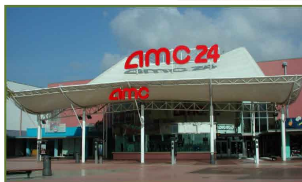
Cubierta para acceso a multicines. Terrassa
