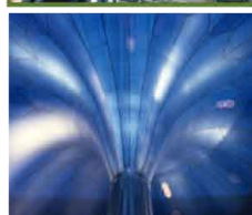
Cubierta sin estructura ni cables con forma de embudo: fijada perimetralmente a la pared a través de una guía, y el cuello del embudo tensado y fijado al suelo actuando de desagüe de la cubierta.
